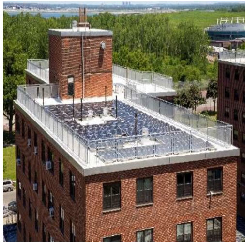
Reparación del techo y del sistema de paneles solares en Ocean Bay (Bayside)
